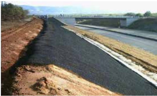
Рис. 2. Укріплення укосів геоматами
