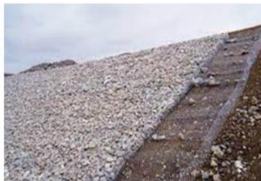
Рис. 4. Укріплення укосів насипів та конусу мостів матрацами Рено
