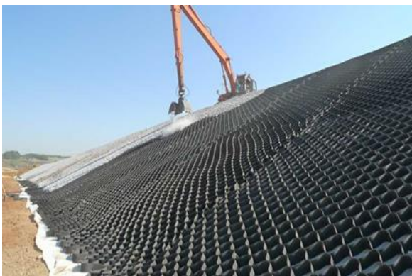
Рис. 1. Укріплення укосів та конусів шляхопроводів георешіткою
