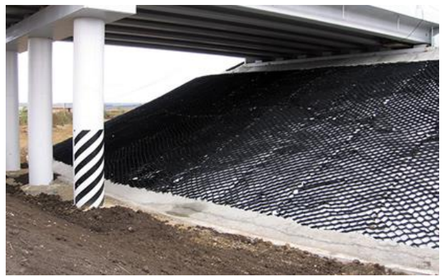
Рис. 1. Укріплення укосів та конусів шляхопроводів георешіткою
