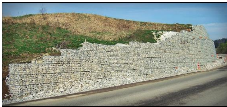
Рис. 3. Укріплення природніх укосів габіонами
